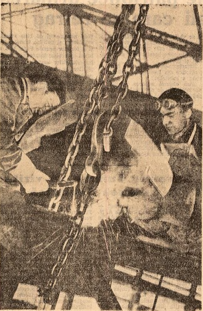
Sudorii Ion Barbu și Ila Gheorghe se ocupă de montajul și producția de la uzina „24 Ianuarie” din Ploiești. Ei dau lucru de cea mai bună calitate și economisesc lunar 25-30 kg. electrici pentru sudură. Iată-i în fotografie lucrînd la o construcție metalică. (Foto: R. Costin)
