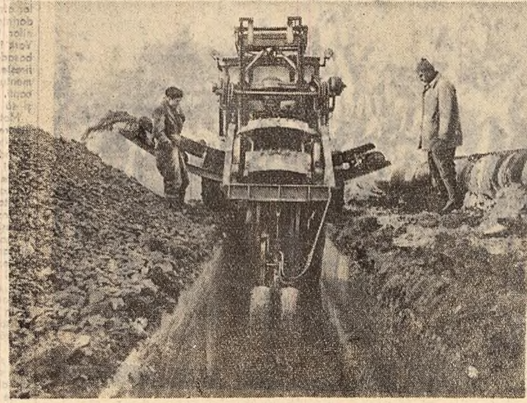
Pe șantierul conductei de țije din Slovãcia. În foto: O mașinã sovieticã modernã, sãpînd șanțul viitoareii conducte.
