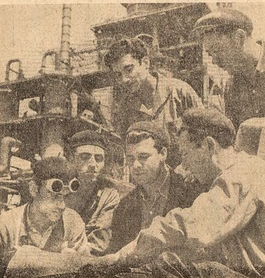
Pe șantierul Combinatului de cauciuc sintetic și produse petrochimice de la Onești se execută lucrări de montaj atât în interiorul unor secții, cit și la instalațiile în aer liber. Brigada de montatori condusă de Ion Barbu este una din brigăzile fruntașe pe șantier. Lucrările pe care ea le execută sînt de bună calitate. În fotografie: cîțiva membri din brigada discută împreună cu maestrul principal Constantin Mirela planul unei lucrări pe care o au de executat.
