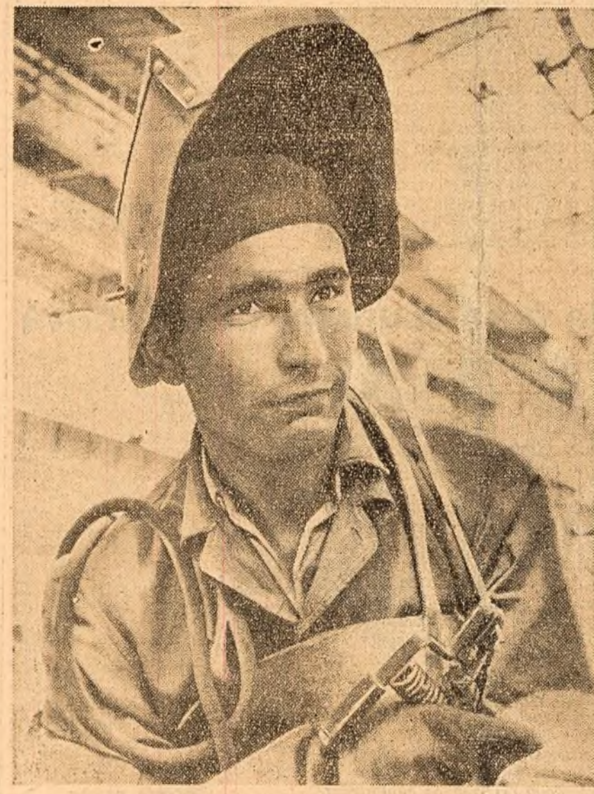
Pe șantierul laminorului de sîrmă, benzii și profilelor mijlocii, de la Combinatul siderurgic Hunedoara, se desfășoară în aceste zile o însuflețită întrecere. Printre frunțașii întrecerii se numără și sudorul Marin Mitran. (Foto Gh. Vințilă)
