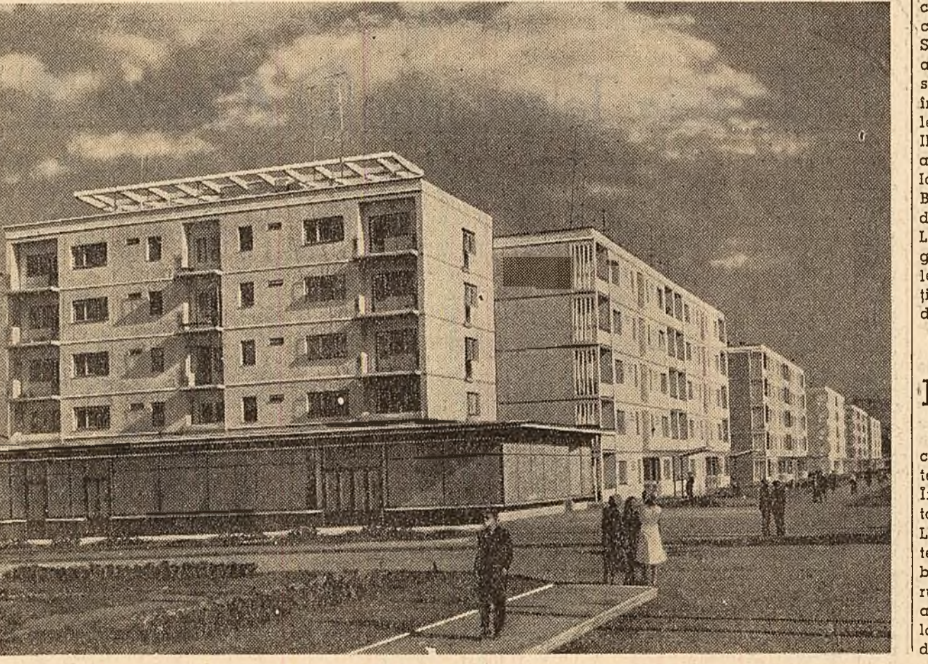
Un colț din lașul de azi: Blocuri noi construite în cartierul „C. I. Parhon”; aici s-au dat în folosință peste 200 apartamente iar altele sînt în construcție. (Foto: Gh. Vințilă)
