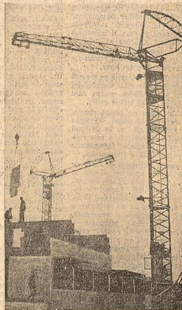
Un șantier de blocuri din prefabricate s-a deschis recent pe șoseaua Giurgiului din Capitală. În fotografie: se lucrează la primul bloc. (Foto: Agerpres)
