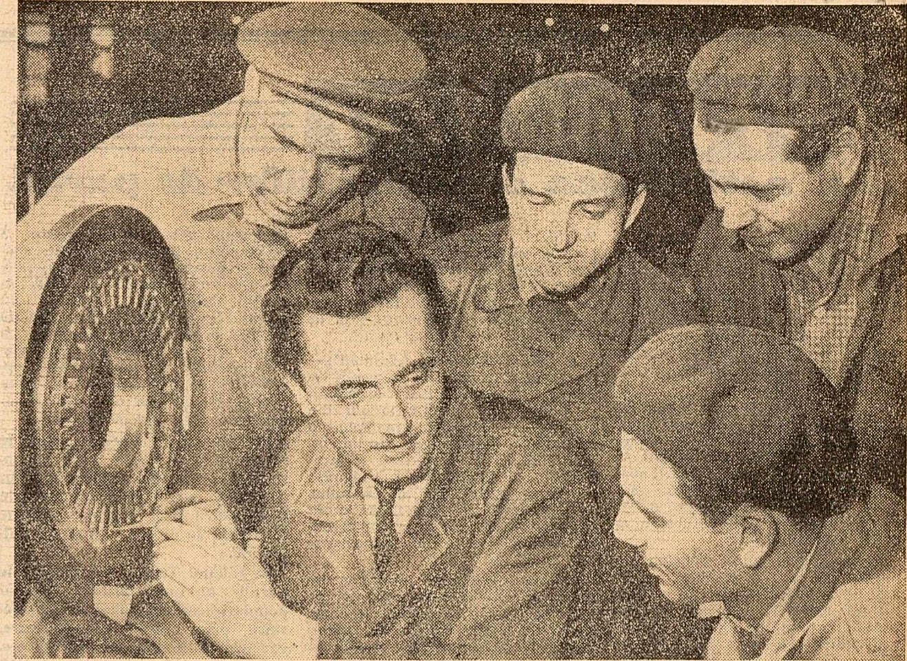
Uzina de motoare electrice București. În secția matrieriei, încă din primele zile ale noului an s-a trecut la producerea unui model nou de matriță de staționare simultană a bobelor pentru motoarele electrice produse în uzină. În fotografie: Maistrul Natic Iosif, Nicolae Creju, Geanță Gheorghe, Ion Teodorescu și Dumitru Tugurlan, discutînd despre noua matriță.
