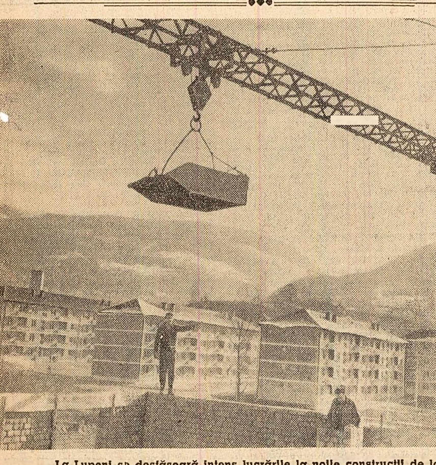
La Lupeni se desfășoară intens lucrările la noul construcții de locuințe. (Foto: Agerpres)
