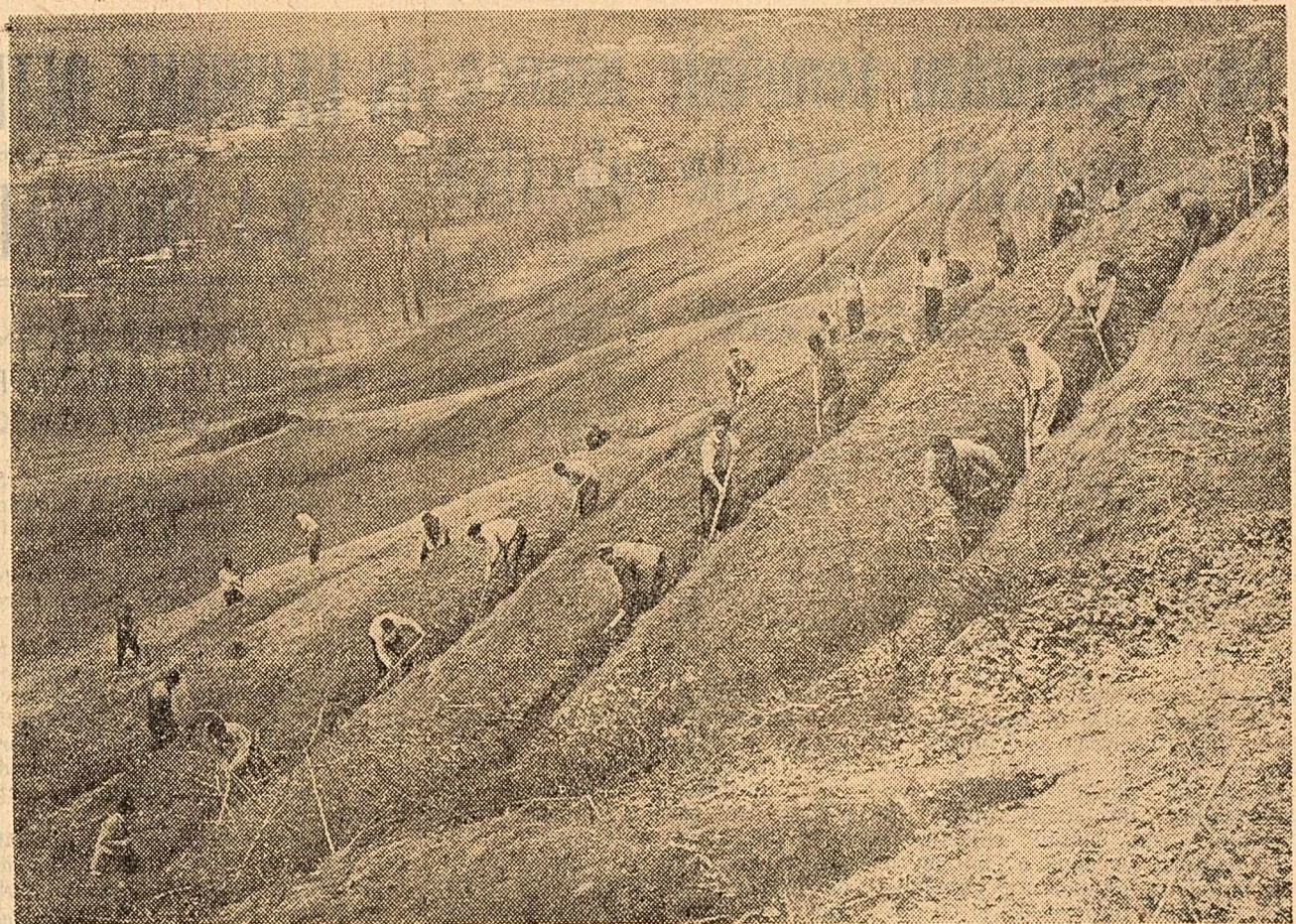
In luna februarie a.c. gospodăriile colective din regiunea Argeș au terasat pentru a planta cu via de vie peste 800 ha terenuri erodate. În fotografie: un aspect de la lucrările de terasare de pe dealul Gîlboacăta, raionul Găești.
