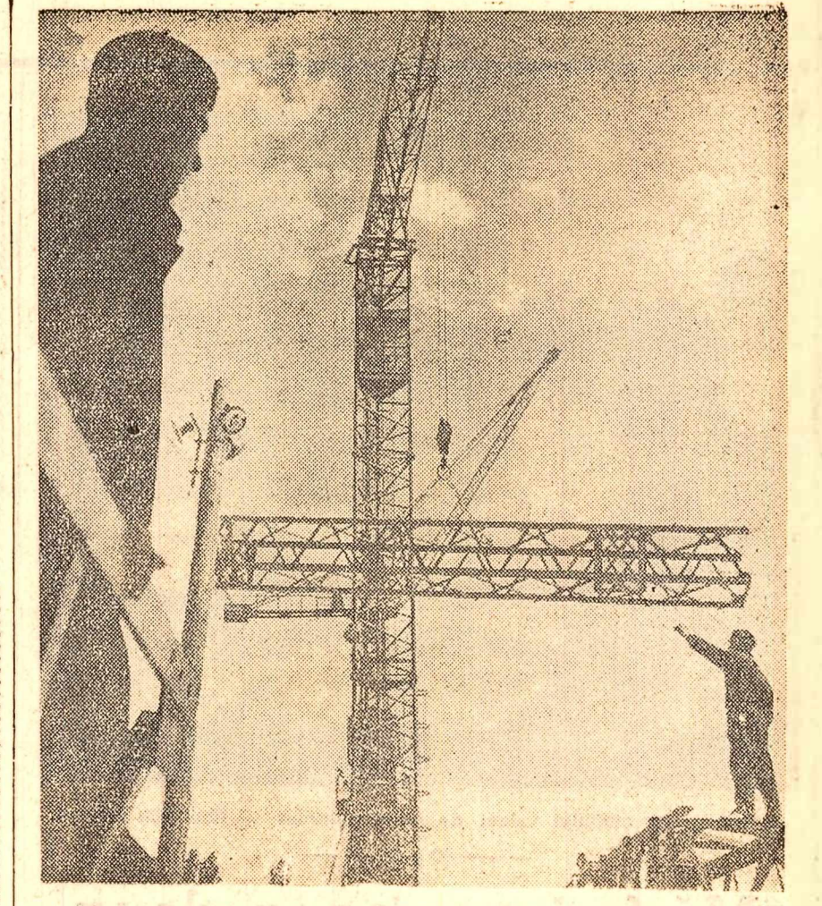
Se montează silpi de înaltă tensiune (Foto: Agerpres)
