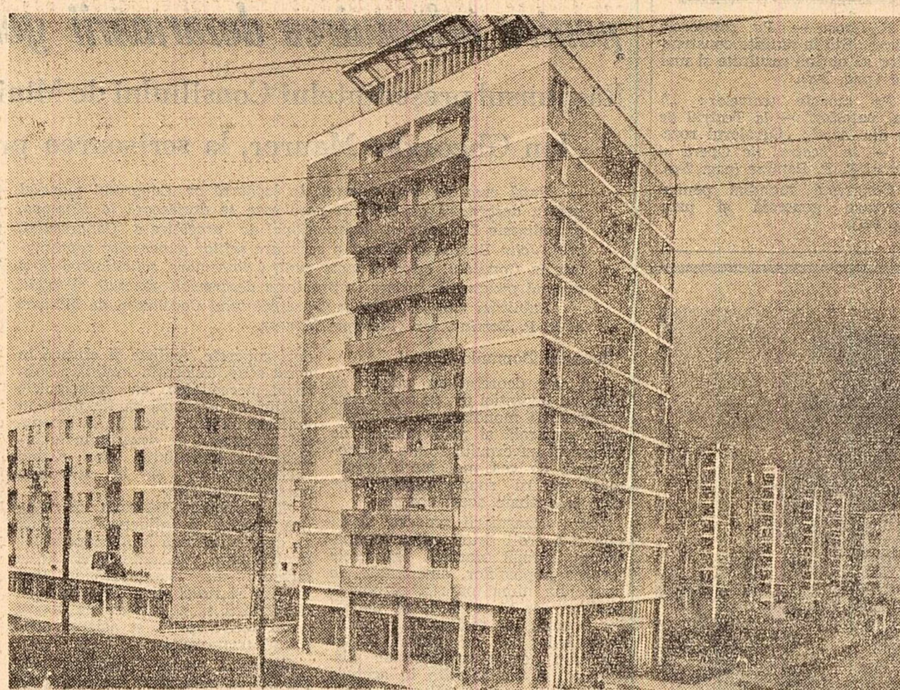
Blocuri ridicate de constructorii orădeni în Piața 23 August.
