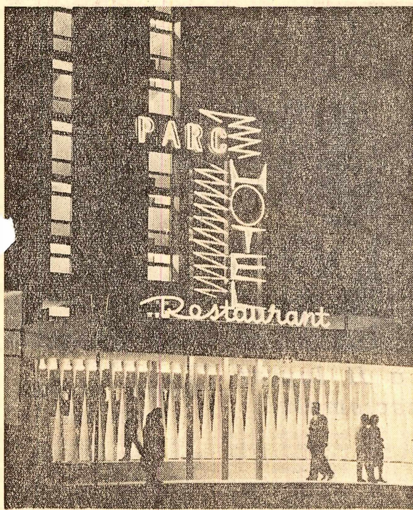
Mameia. Noaptea, lumina fluorescenta subliniază frumuseea nolor constructii.
