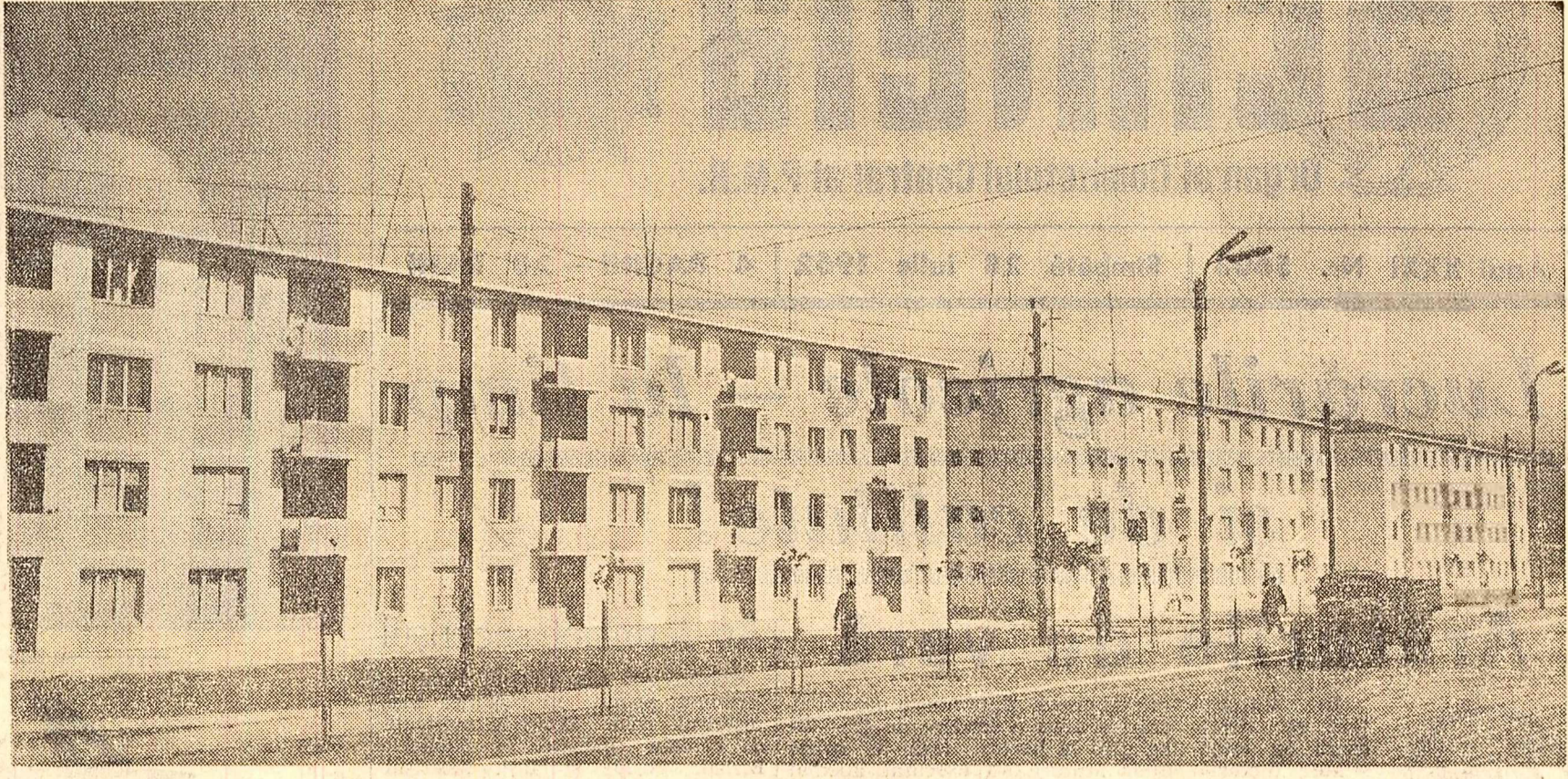
Noi blocuri de locuințe date de curind în folosință în plața gării din Hunedoara
