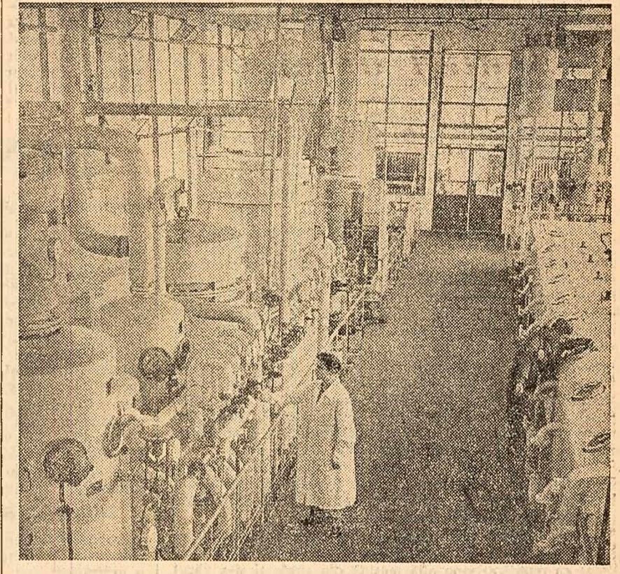
Fabrica de ulei din raionul „N. Bălcescu”-București. Instalația de distilare din secția de extracție continuă. (Foto: Agerpres)
