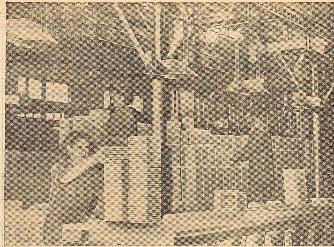
Combinatul chimic Timăveni. Hala de încălzire a plăcilor de faianță pentru arderea în cuptoare. (Foto: R. Costin)
