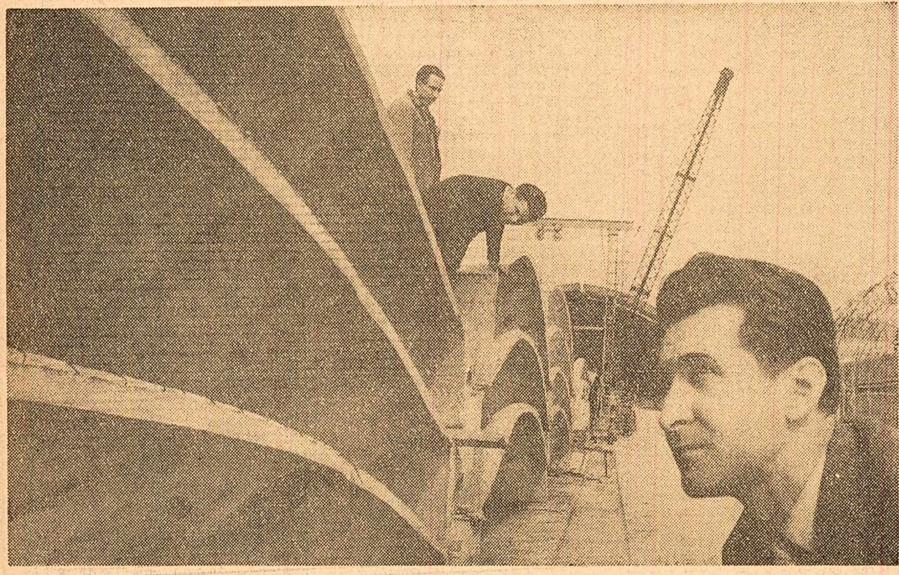
Inginerul Mircea Soare, cercetător la INCERC-București, alegînd din depozitul Institutului plăcile de armociment pentru montarea unei hale experimentale. (Foto: Agerpres)
