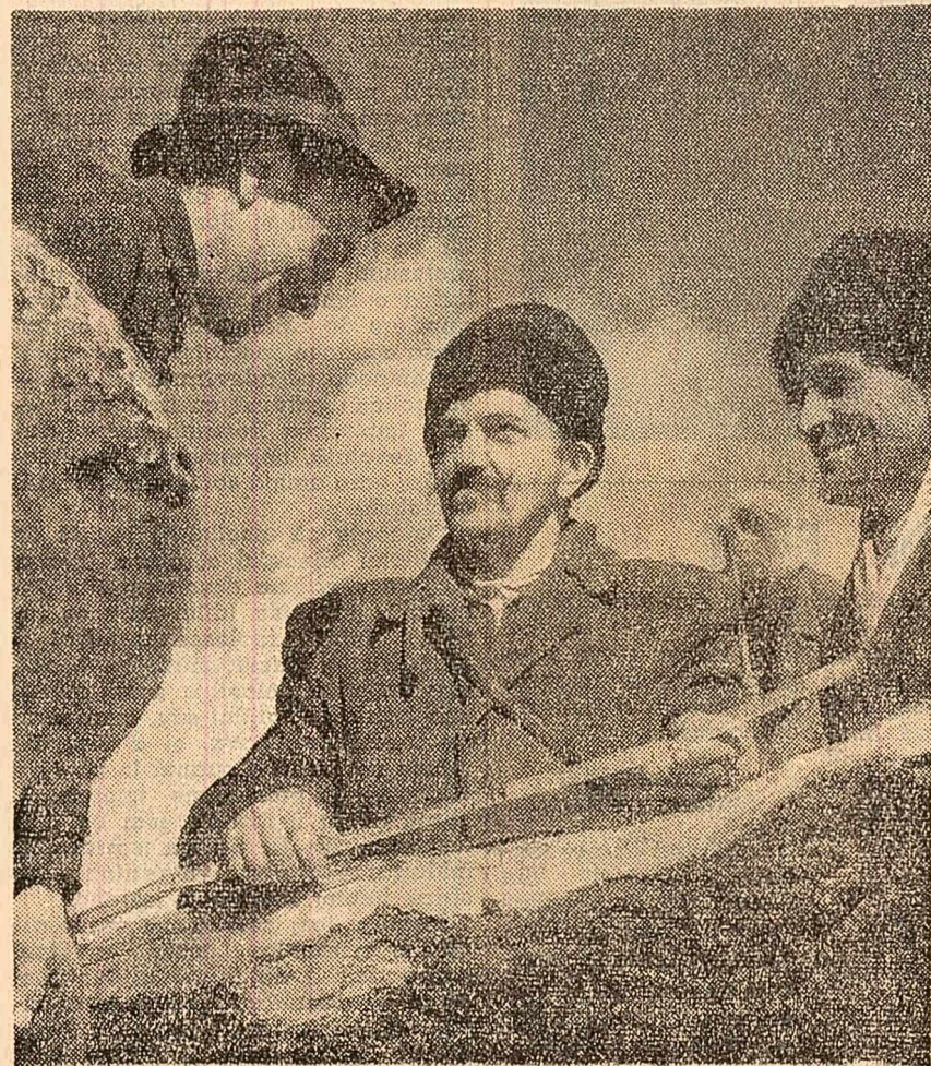
La gospodăria colectivă din comuna Ardasul, raionul Șomcuta Mare, regiunea Maramureș, colectivii au început lucrările la construcții. (În acest an, în gospodărie se vor construi încă două școli, o pușcărie, magazie și ateliere). În fotografie se vede biroul de construcții Gheorghe Lăuran, dulgherul Vasile Ciț și Vasile Fomea sortind lemnul de construcție.
