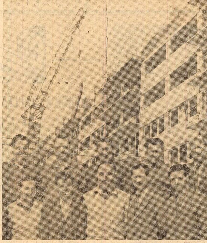
Constructorii de pe șantierul nr. 1 din Șoseaua Giurgului, și întreprinderii de construcții locuințe - București, obțin în aceste zile noi realizări în grabirea lucrărilor și ridicarea calității lor. Vă prezentăm în fotografie, cîțiva constructori evidențiați de pe acest șantier (de la stînga la dreapta) rîndul de jos: Nistor Zamfir, Petre Siroș, Dumitru Udencu (șef de bloc), Gheorghe Ciocoiu, Florian Peștera, rîndul de sus: Valentin Potlesak, Dumitru Constantin, Petre Macedonski, Petre Cojocaru și Vasile Iagăr. (Foto: A. Catojan)
