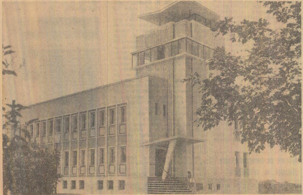
Noua clădire a Institutului meteorologic de la Băneasa
