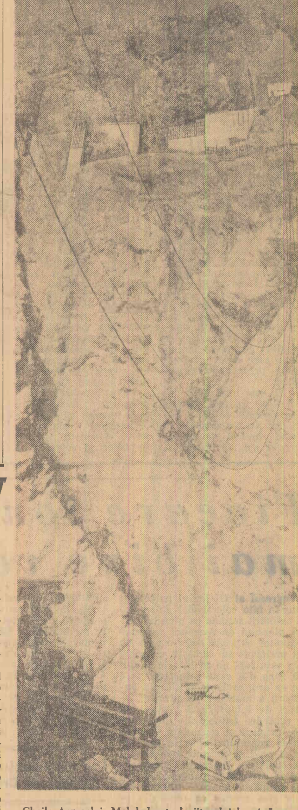
Cheile Argeșului. Malul drept al viitorului baraj. În partea de sus a fotografiei se văd câteva lucrări de construcții în plină desfășurare. Porțiunea umbrată din fotografie reprezintă fagșul tăiat în peretele abrupt al Cheilor, locul unde pieptul de beton al barajului se va încastra în peretele de stîncă. La talpa barajului, unde circula mașinile, a fost pînă nu demult vechea albie a Argeșului, deviat acum pe un traseu nou, subteran. (Foto: A. Cartoian)
