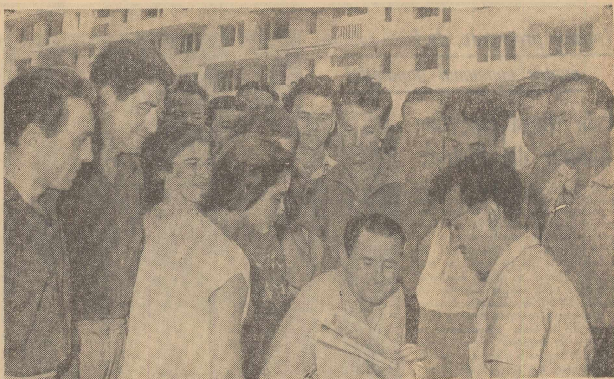
Constructorii de pe santierul din str. Sergent Nişu Vasile al I.C.M. nr. 4 au dobîndit o bogată experientă in folosirea de metode înaintate la construcţia blocurilor de locuinte. Ei au experimentat si folosit cu bune rezultate o serie de materiale noi, realizind o calitate superioară la finisarea apartamentelor. Iată-l in fotografie pe ing. Mircea Ivanciu, şef de lot, împărtăşind unui grup de constructori din experienta acumulată la blocurile 13 si 14 recent date in folosinta.
