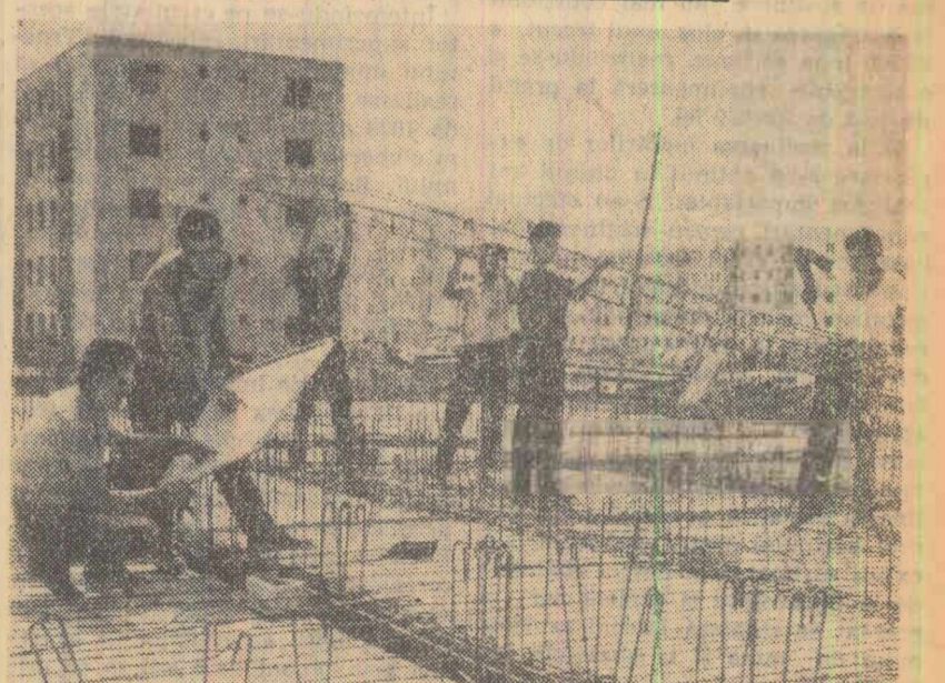
Santierul Jiului-Scinteia din Capitală. O parte din membrii echipei conduse de Gheorghe Turcu montînd stîlpii de rezistență la blocul turn cu 10 etaje.
