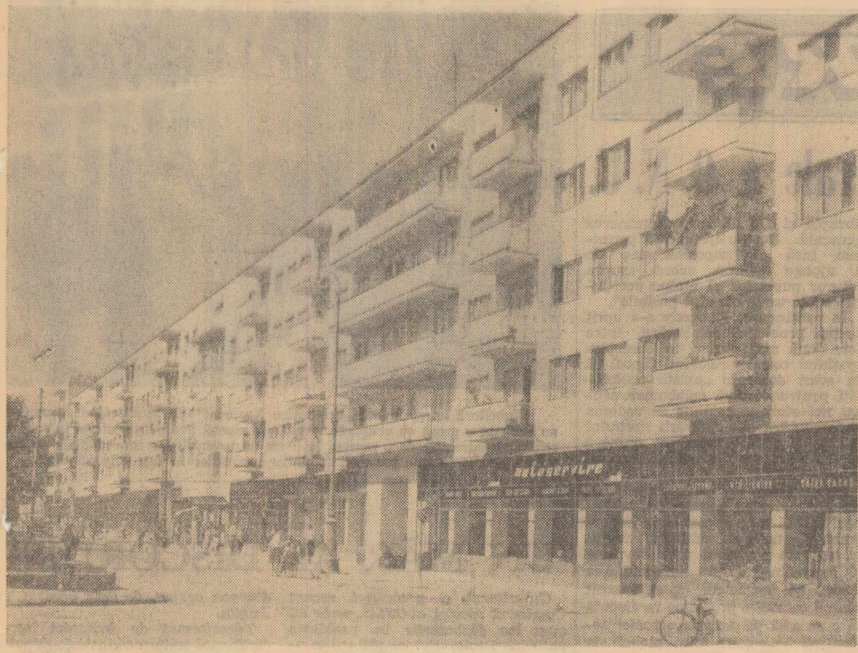
Noi construcții de locuințe pe bulevardul Republicii din Arad. (Foto: Gh. Vintilă)
