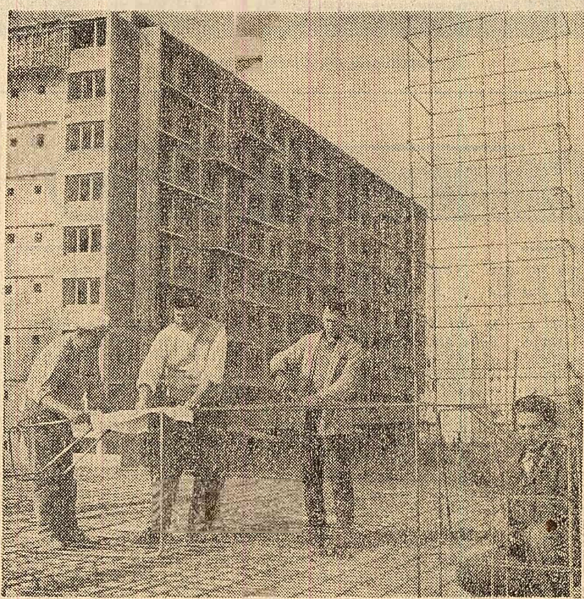
Constructorii de pe șantierul nr. 2 din cartierul Sargent Nițu Vasile din Capitală au dat în acest an în folosință 920 de apartamente, dintre care 102 apartamente cu 90 de zile înainte de termen. În prezent se lucrează intens la alte blocuri. În fotografie: Brigada de fierărie-betonieri condusă de Andrei Stoica, evidențiată în întrecerea socialistă, montind armătura plăcii peste parterul noului dispensar aflat în construcție. (Foto: AGERPRES)
