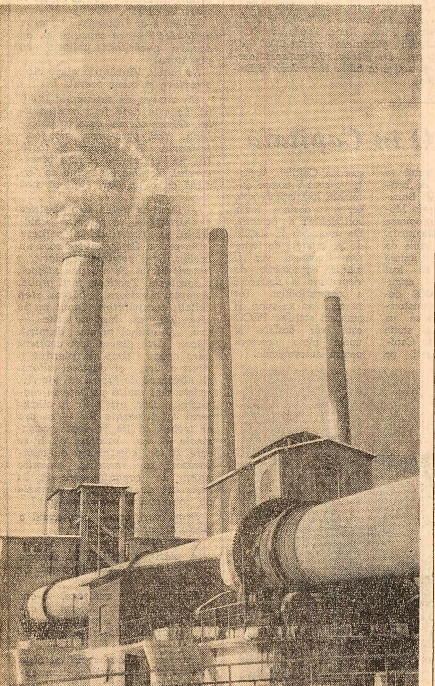
Fabrica de ciment Fieni — cuploarele de clincher.
