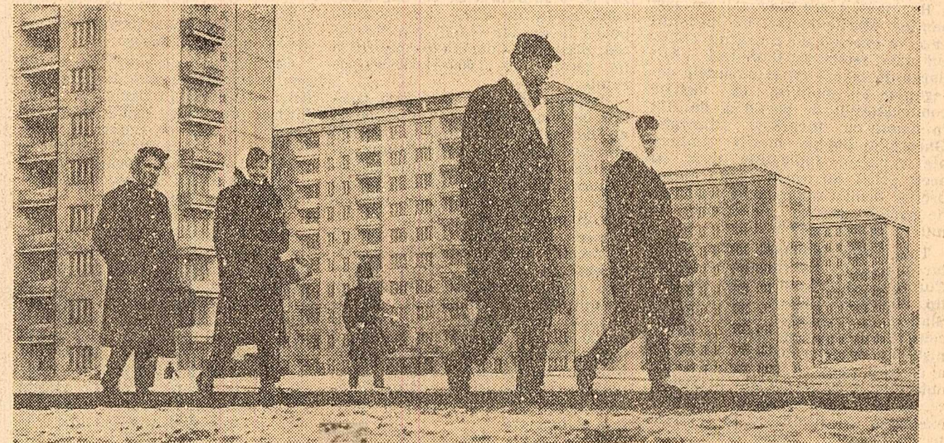
Anul trecut, în orașul Hunedoara s-au construit numeroase blocuri, printre care și acestea din fotografie, cu ajutorul cotrajelor glisante. Foto: GH. VINTILA
