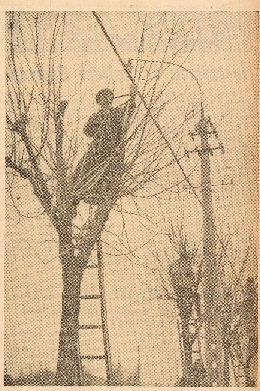
Nu este vorba numai de fasonatul coroaneli la pomii de pe marginea goselei Giurgiului din Capitală ci și de protejarea rețelei electrice și telefonice.
