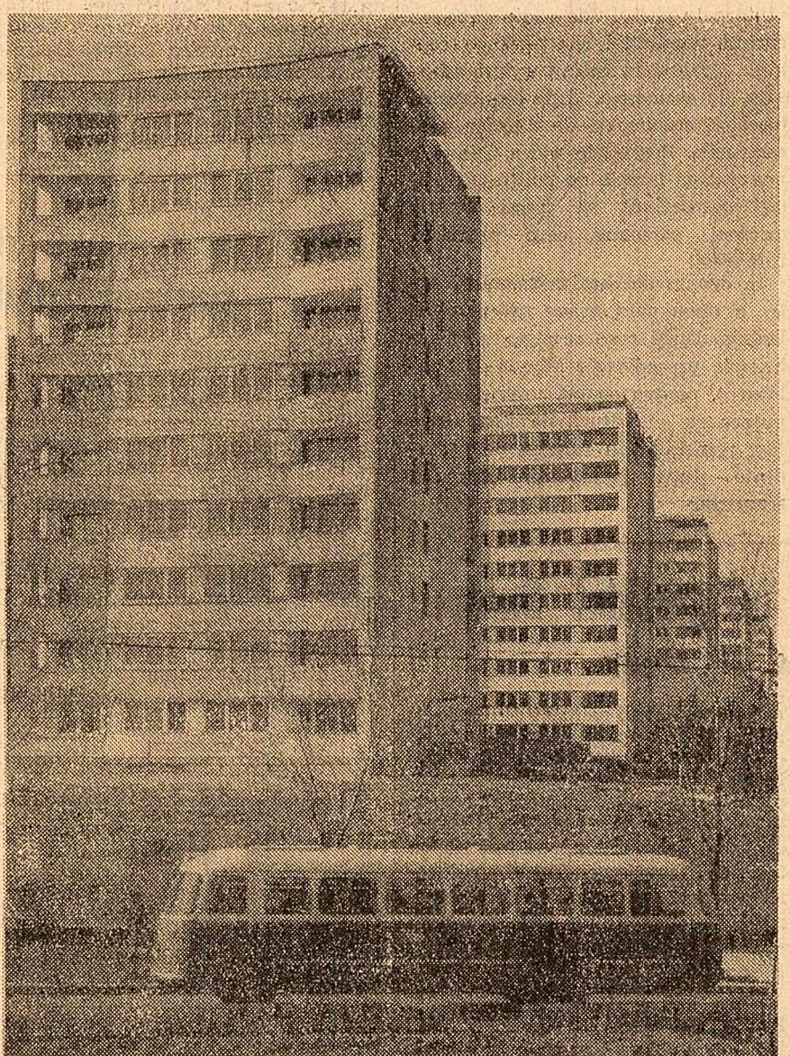
Blocurile cu 10 nivele construite cu ajutorul cofrajelor gisante pe șoseaua Oleniței. Ridicarea structurii de rezistență a blocului durat mai puțin de 13 zile.
