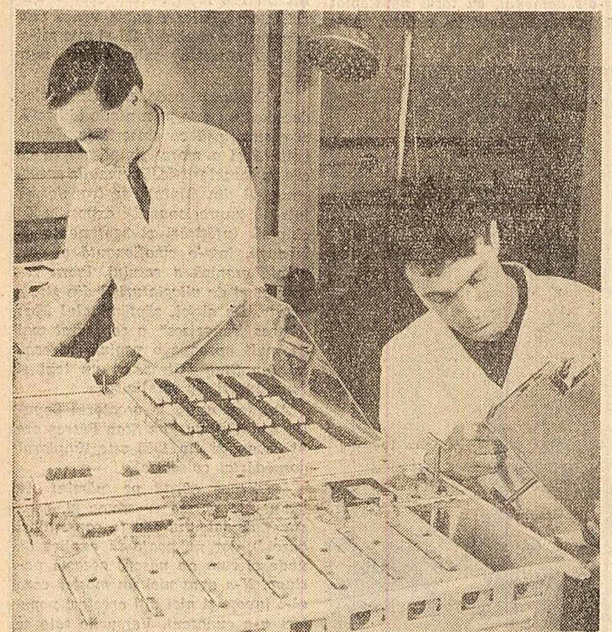
Specialiști din R.D. Germană au construit un electroencefalograf pe bază de blocuri tipizate, scheme imprimate și tranzistori, care permit înregistrarea simultană și cu mare precizie a opt trasee bioelectrice diferite. În fotografie: Aparatul este supus ultimei verificări.
