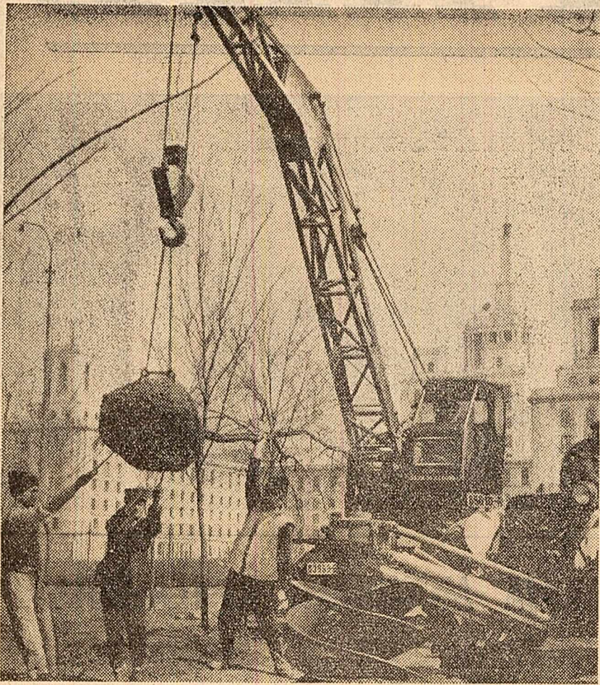
Intreprinderea horticolă 1 Mai a început plantarea pomilor pe terenul rezervat spațiilor verzi
