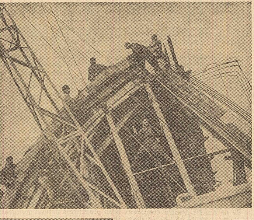
Fotografia de sus reprezintă un aspect de lucru pe șantierele Fabricii de stofă de mobilă. Muncitorii din brigăzile de fierar-betonieri condusă de Constantin Mulescu și de dulgheri condusă de Bodo Andrei — brigăzi fruntașe în întrecerea socialistă pe 1963 — execută acoperișul halei principale a fabricii.
