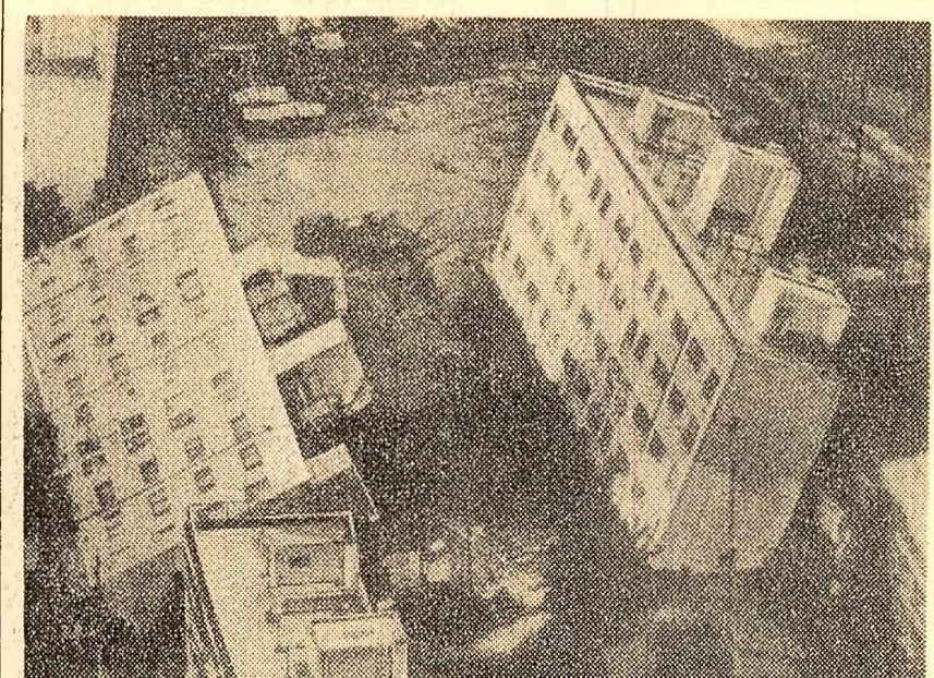
Recent, în nord-vestul Japoniei a fost înregistrat un puternic cutremur. Orașul Niigata a avut mult de suferit de pe urma cutremurului. În fotografie: Un bloc de patru etaje răsturnat.
