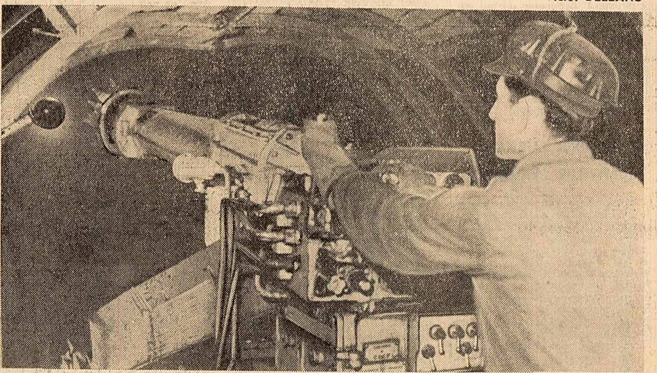
Unul dintre utilajele moderne folosite la înaintări de către minierii din Valea Motrului
