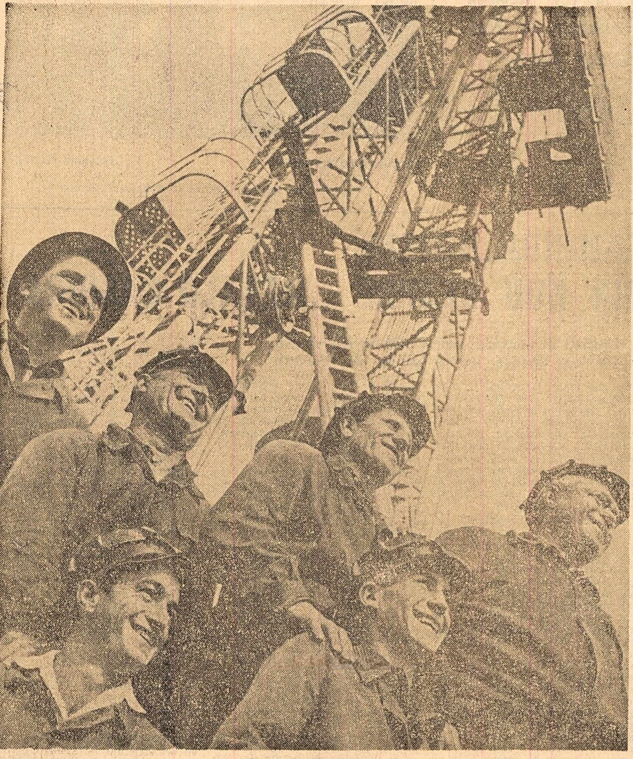
Cu ajutorul unei moderne instalații de foraj 3DH-200 A s-a forat cea mai adâncă sondă de la noi din țară, care a atins adâncimea de 5315 m. În fotografie, câțiva dintre membrii brigăzii care a lucrat cu această instalație (de la stînga la dreapta): Gheorghe Piepșu, mecanic, Constantin Pănd, sonder-șef, Constantin Iorga, podar, Ion Ilie, ajutor de sonder-șef, Ilie Constantin și Ion Pană, sonderi Foto: R. Costin
