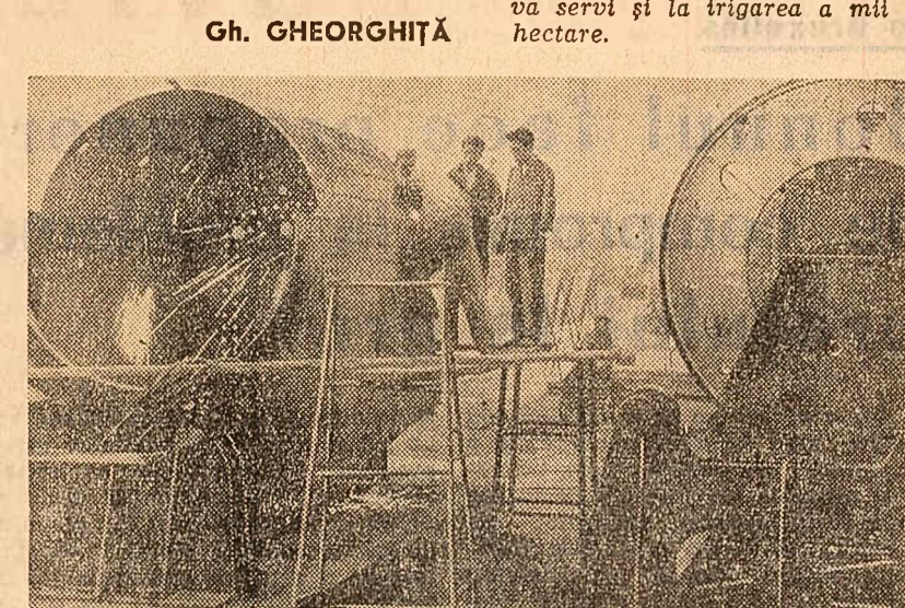
Lucrările de construcție a Uzinei de locomotive Tatung, din provincia Șamsi (nordul Chinei) sînt în curs de terminare. În fotografie: Intr-una din secțiile uzinei se asamblează un boiler
