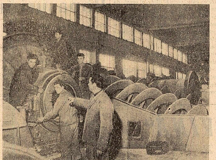
Un veteran al marilor șantiere: Iosif Ceavdari. Împreună cu brigada sa lucrează la montajul modernelor agregate
