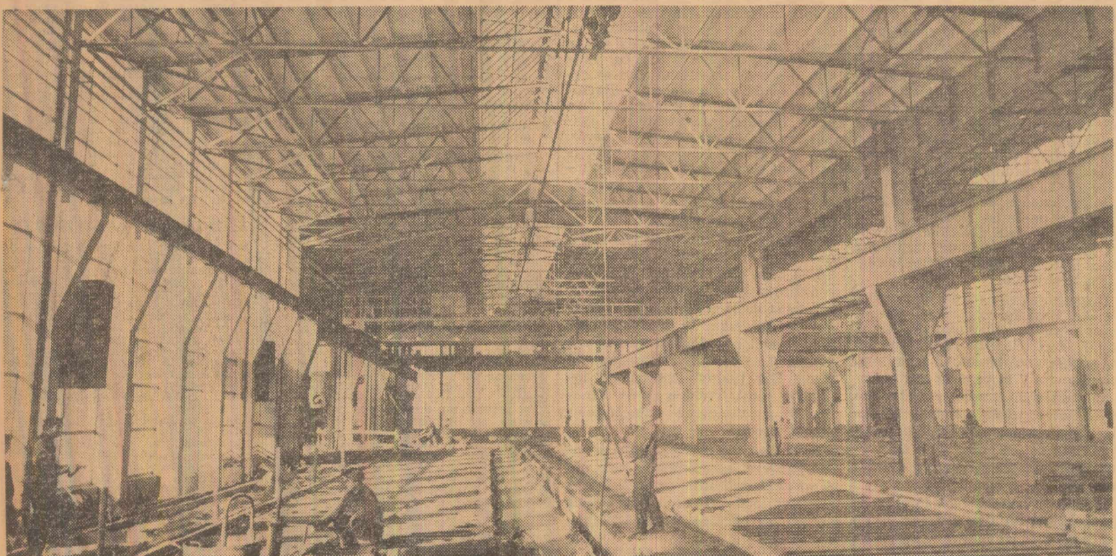
Șantierul fabricii de beton celular autoclavizat din cadrul Complexului Industrial Militari-București
