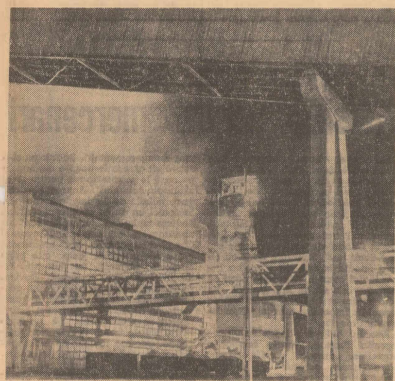
Fabrica de zahăr din Tg. Mureș. Se lucrează din plin ziua și noaptea
