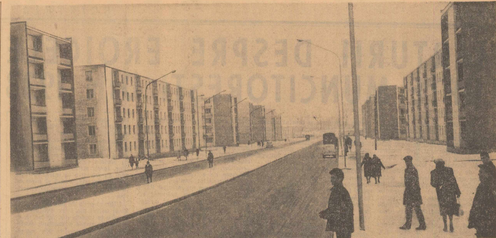
Pitești. Noi blocuri de locuințe în cartierul Ceal
