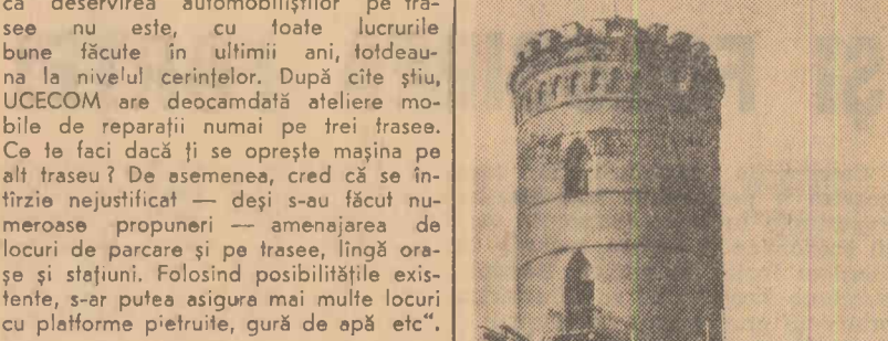
Lucrări de restaurare la turnul Chindiei din Tîrgoviște
