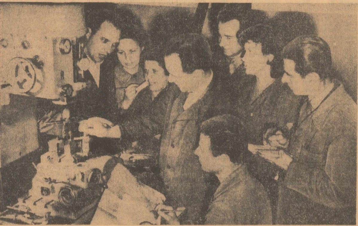
Pentru ridicarea calificării controlorilor de calitate, la Uzina de mecanică fină din Capitală se fac numeroase demonstrații practice. În fotografie: Se explică controlorilor modul de verificare a dimensiunilor unui dispozitiv. Foto: Gh. Vințilă
