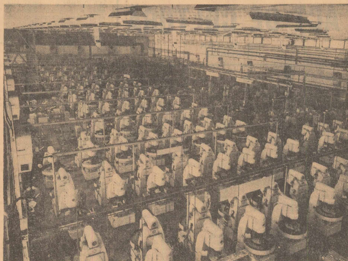
În ultimele 3 luni în secțiile uzinei „Rulmentul” din Brașov au fost montate numeroase mașini și agregate cu un înalt nivel tehnic. Printre acestea se numără 23 de mașini pentru plii și rectificat bile, o instalație electronică pentru sortat și controlat calitatea bilelor și roletor cu o precizie de o zecime de micron. Atenția colectivului este îndreptată în prezent spre folosirea cu maximum de randament a instalațiilor și mașinilor noi. În fotografie: a doua secție uzinei
