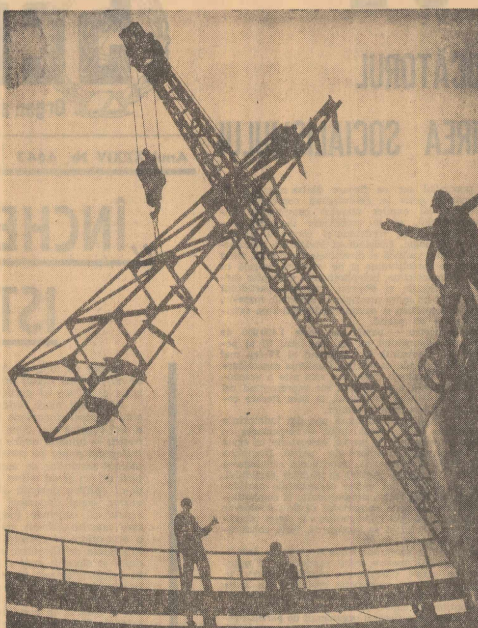
Modernizare. La Uzina metalurgică din Coșca Mică se montează rațele unei instalații de separare a minereurilor
