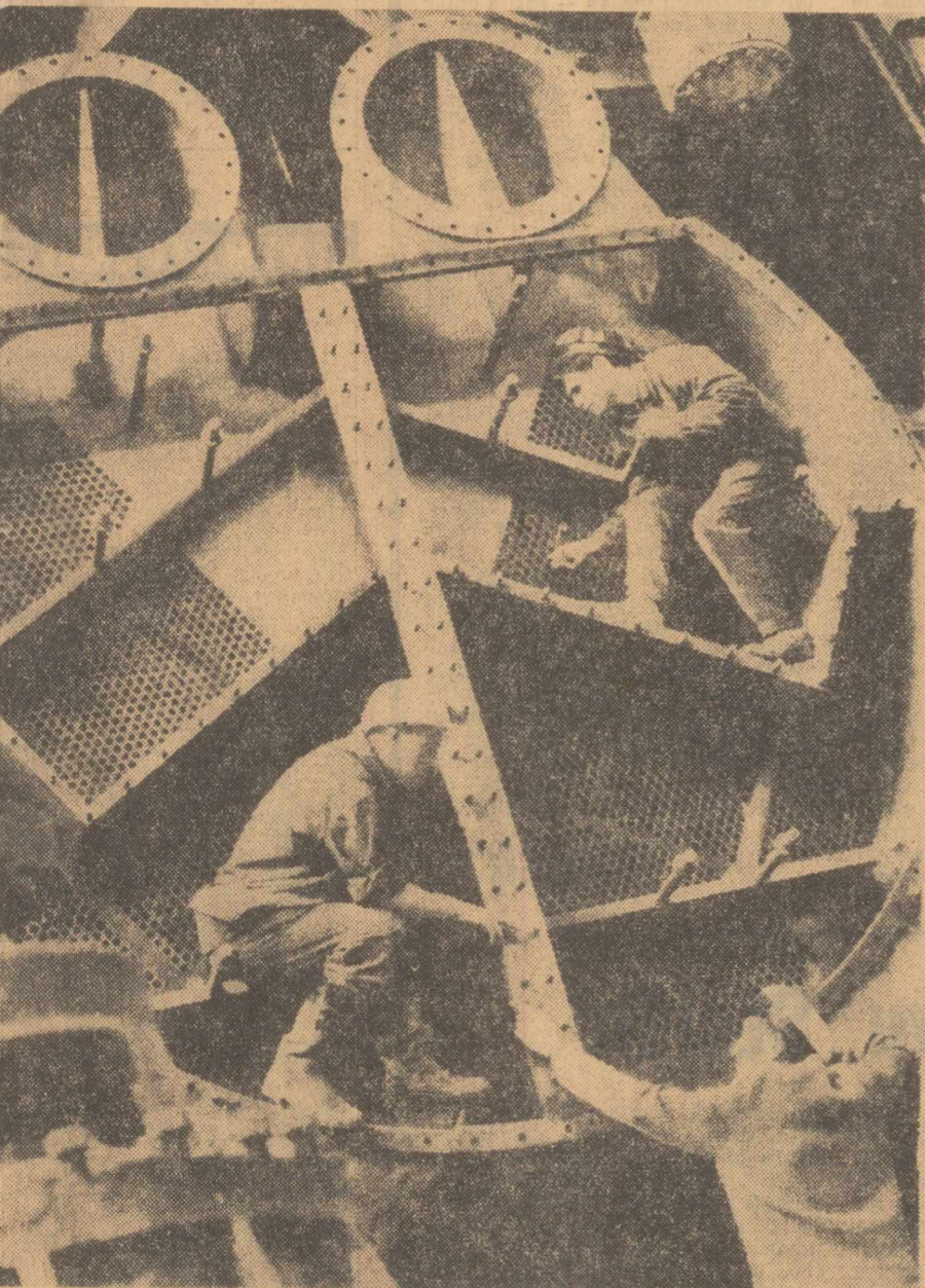
Șantierul Centralei electrice de termoficare din Iași. Se montează condensatorul de la turbogeneratorul nr. 1 de 25 M.W. Foto: R. Costin
