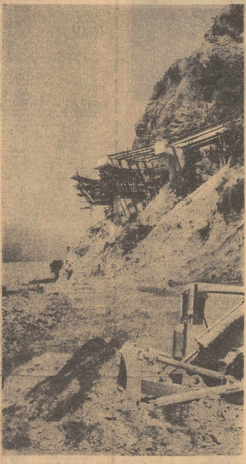
Lucrări de construcție a viaductului de pe șantierul Hidrocentralei Porțile de Fier. Foto: Gh. Amuzu
