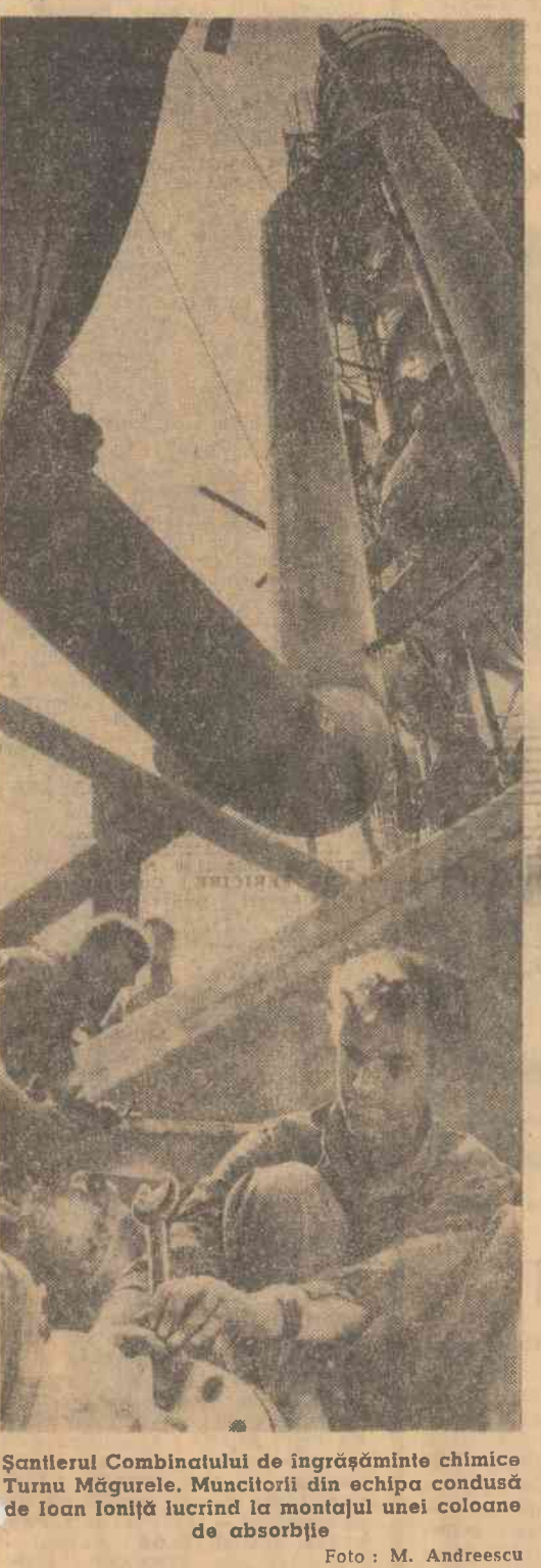
Șantierul Combinatului de îngrășăminte chimice Turnu Măgurele. Muncitorii din echipa condusă de Ioan Ioniță lucrează la montajul unei coloane de absorție
