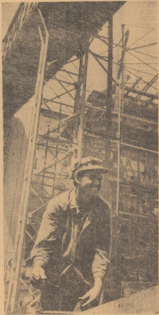
Dumitru Roșu, unul dintre constructorii centralei electrice de termocăutare de la C.I.L. Tr. Severin, realizează numai lucrări de bună calitate
