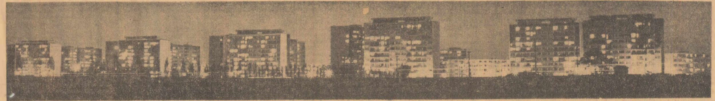
Noul cartier de locuințe Jiului-Scintela din Capitală
