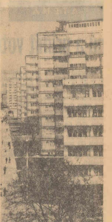
În orașul Wrocław (R. P. Polonă) se înalță numeroase blocuri de locuit. În fotografie: Vedere din Gajovice, un ralon al Wrocławului
