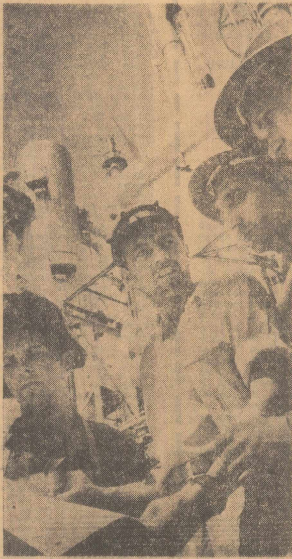
Unul din noulle obiective aflate în construcție la Combinatul chimic din Craiova este fabrica de acelul. Brigada de montaj condusă de Pavel Ciupercă (al doilea de la stînga la dreapta) a terminat înainte de termen montajul secției de piroxid.
