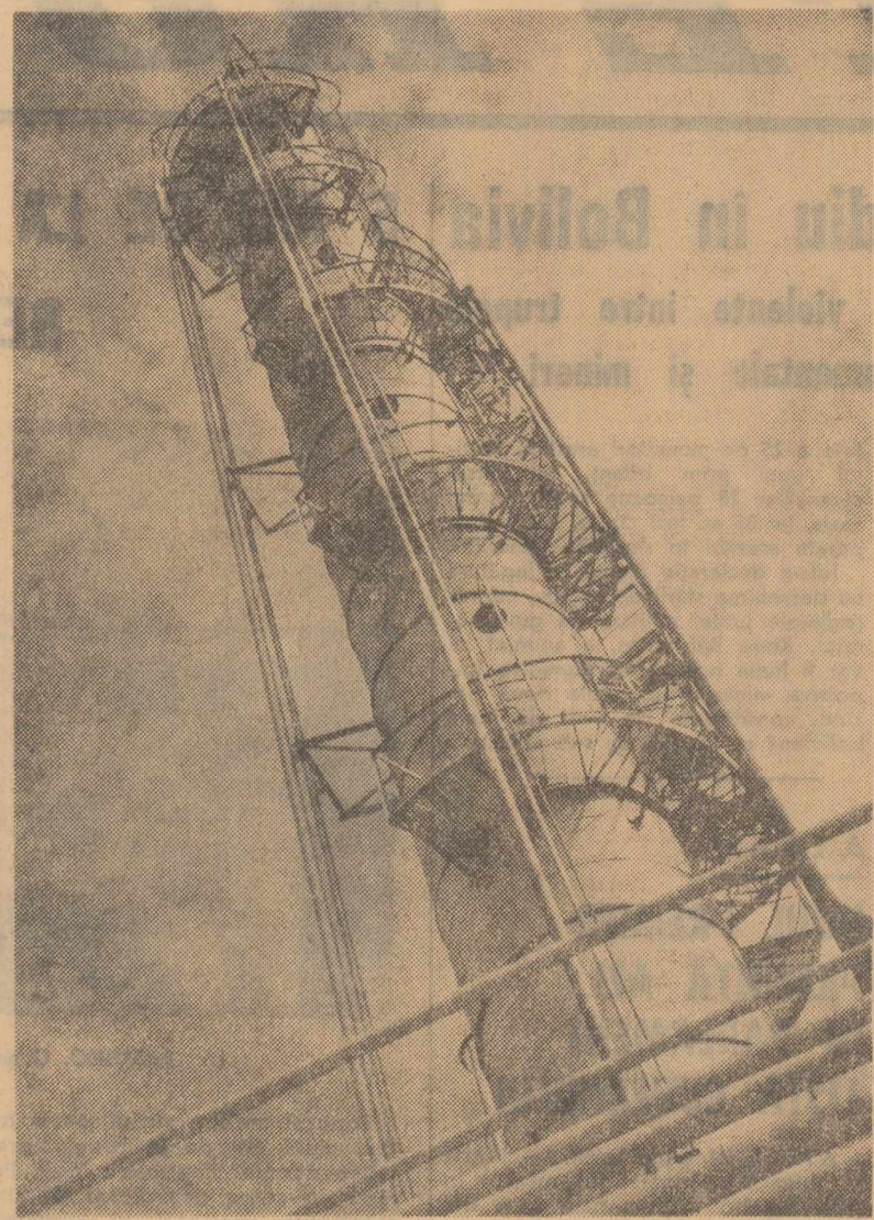
Orașul Gheorghe Gheorghiu-Dej. Una din instalațiile noului complex de reformare catalitică a rafinării. Foto: Gh. Vințilă
